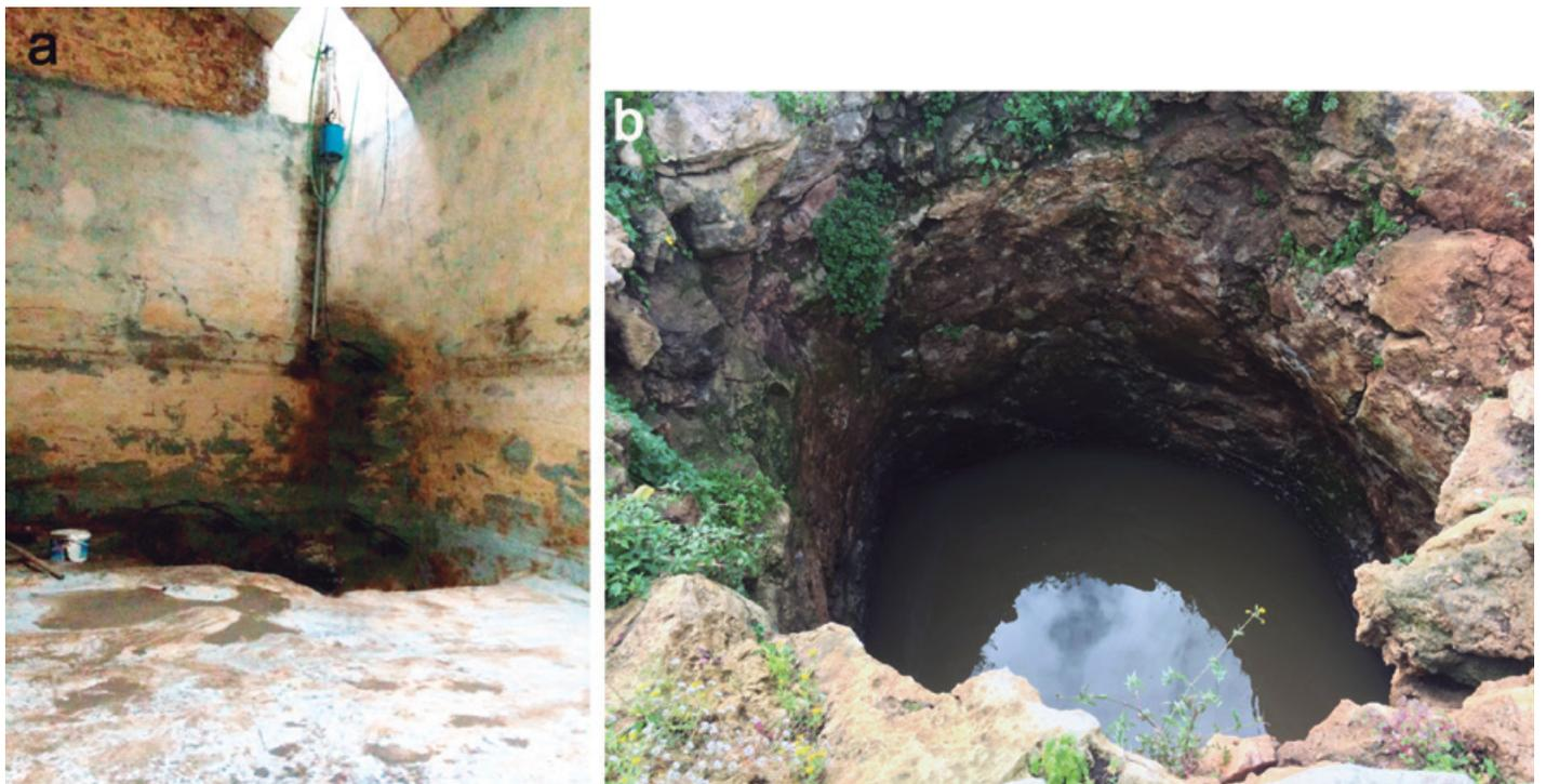
**Figura 20.** (a) Interior de una cisterna de una casa rural menorquina. En este caso está recubierta de una fina capa de cemento y cal. También dispone de una balsa de decantación. (b) Cisterna del círculo 6 de Torre d'en Galmés a pleno rendimiento en otoño de 2018.
